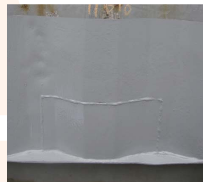
第五步：打磨、油底漆和麵漆
