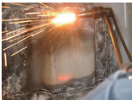
第一步：氣割切除受損部位
