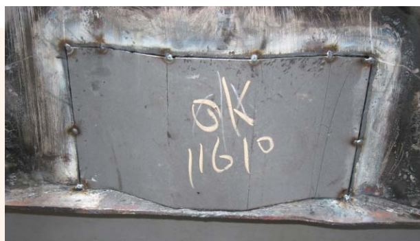
第二步：安裝替換件並點焊，檢查裝配品質
