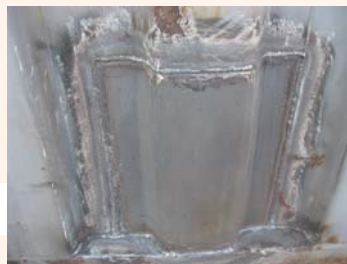
前旁板部分更換
